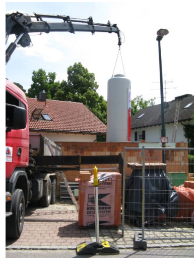
Bild 4: Einbringen des Schichtlanzen-Wärmespeichers in das Sonnenhaus
