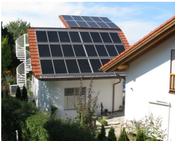
Bild 1: Südansicht Sonnenhaus, rechts Bestandsgebäude
